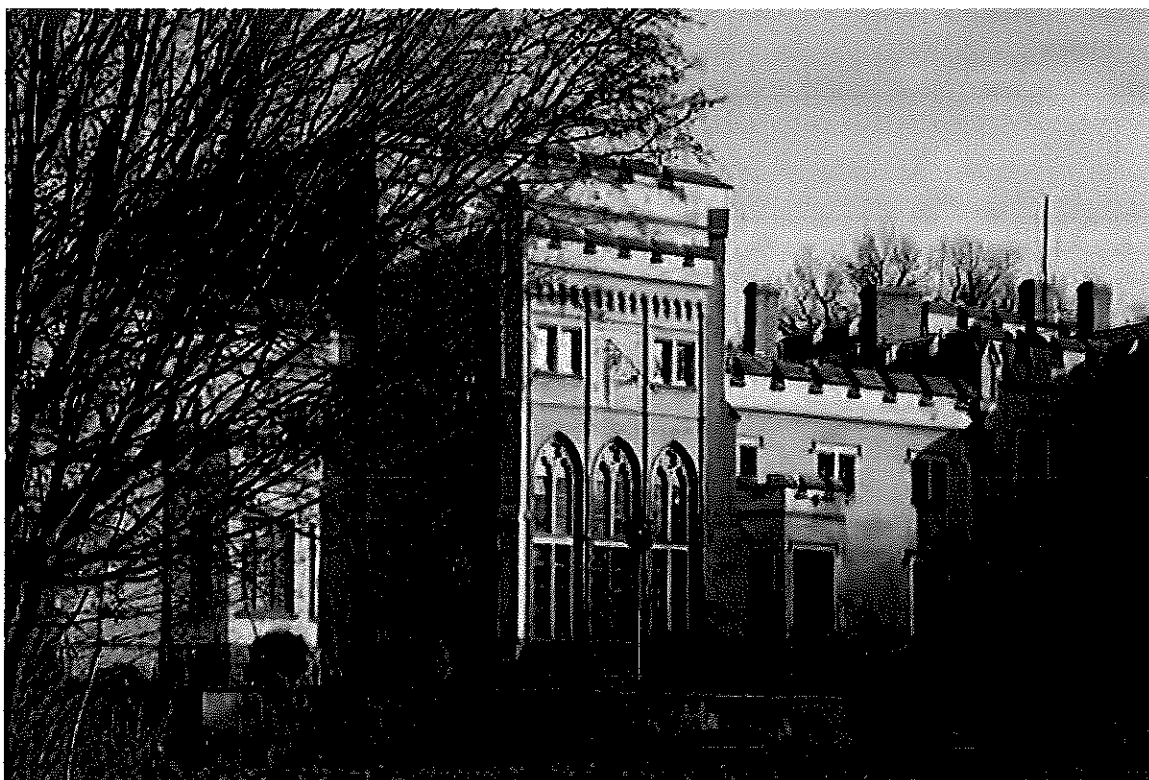
Pałac w Jarocinie – elewacja ogrodowa
